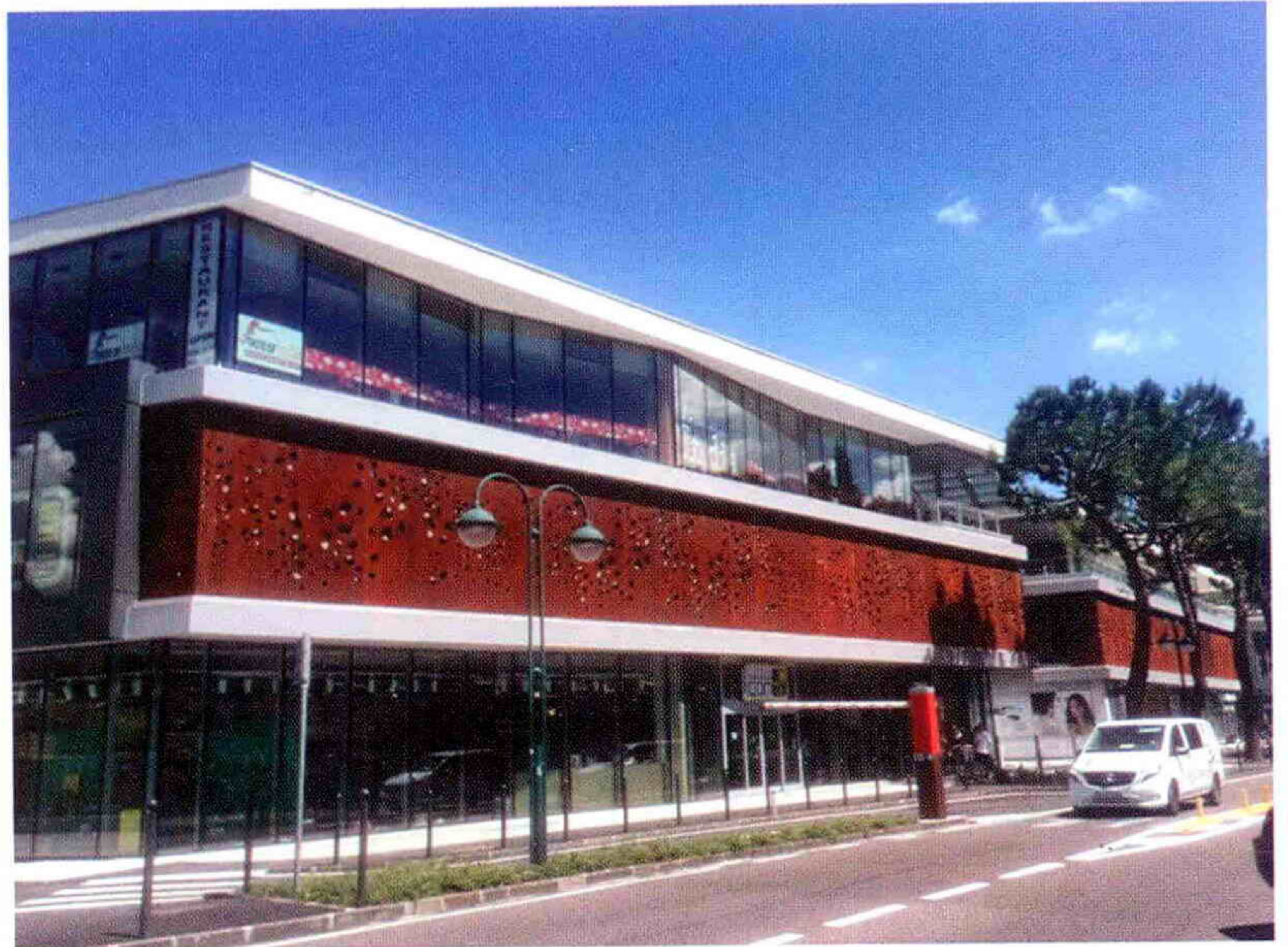
На фасадах здания применены панели из анодированного алюминия, выполненные по технологии ClassicElox
